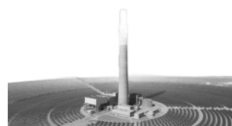
太阳能光热发电 CSP Power Plant
